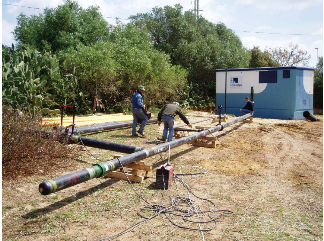
Soldando isométrico de entrada a la ERM 04-03-09
