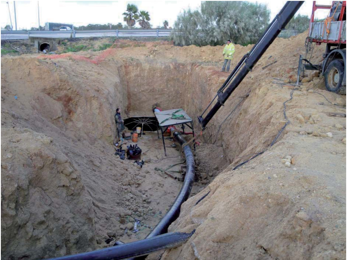
Perforaciones en la rotonda de acceso a El Puerto de Santa María, Cádiz. Febrero 2010.
