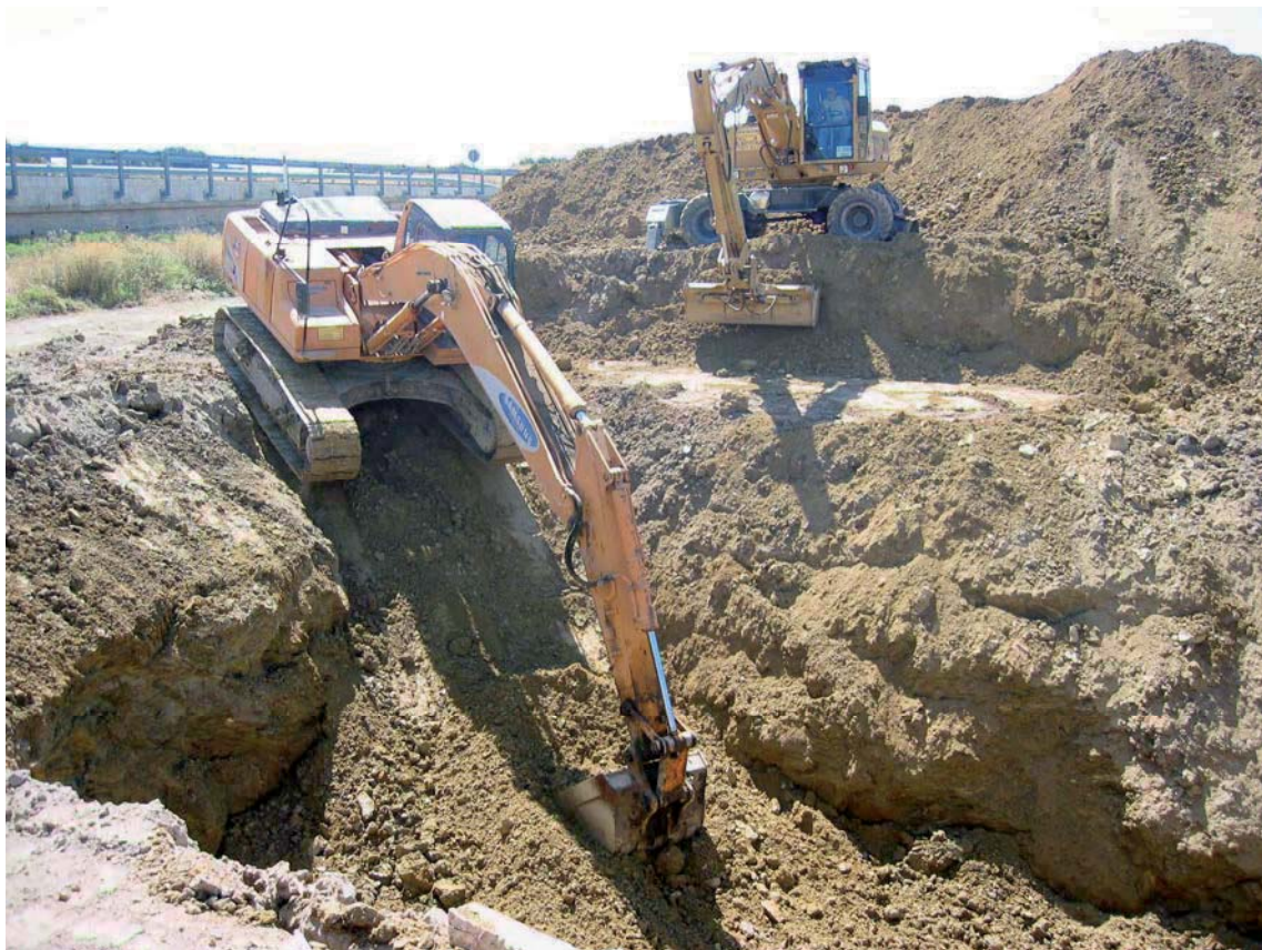
Excavaciones de fosos de entrada de una perforación horizontal.
