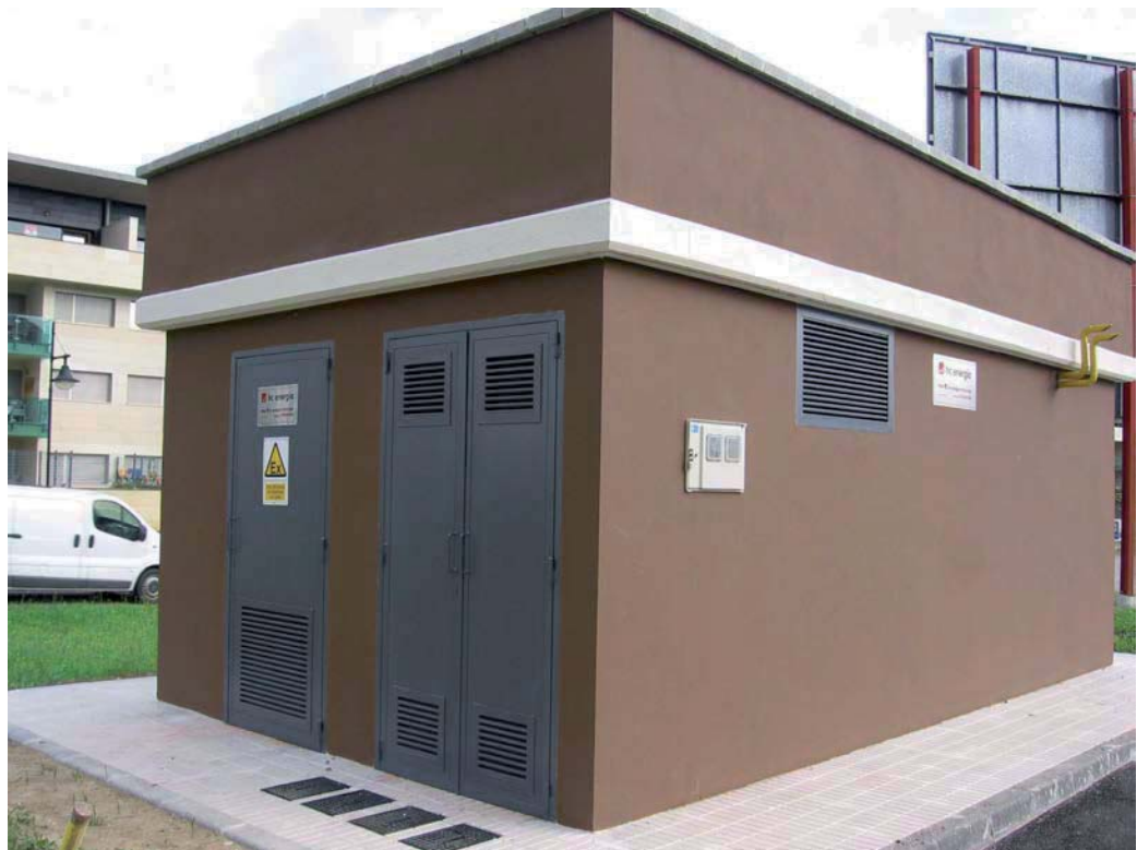
Caseta de ERM de distribución en la Arquera, Asturias, julio 2010.
