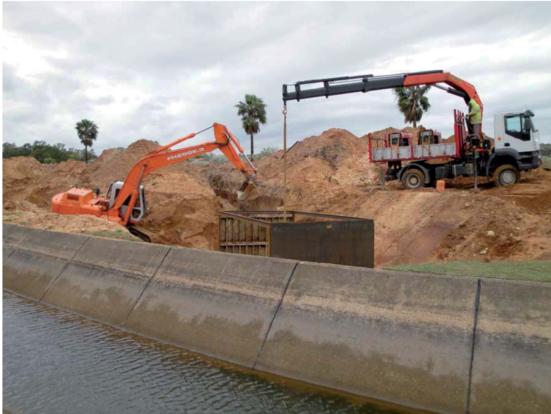
Perforación horizontal bajo un canal de regadío.
