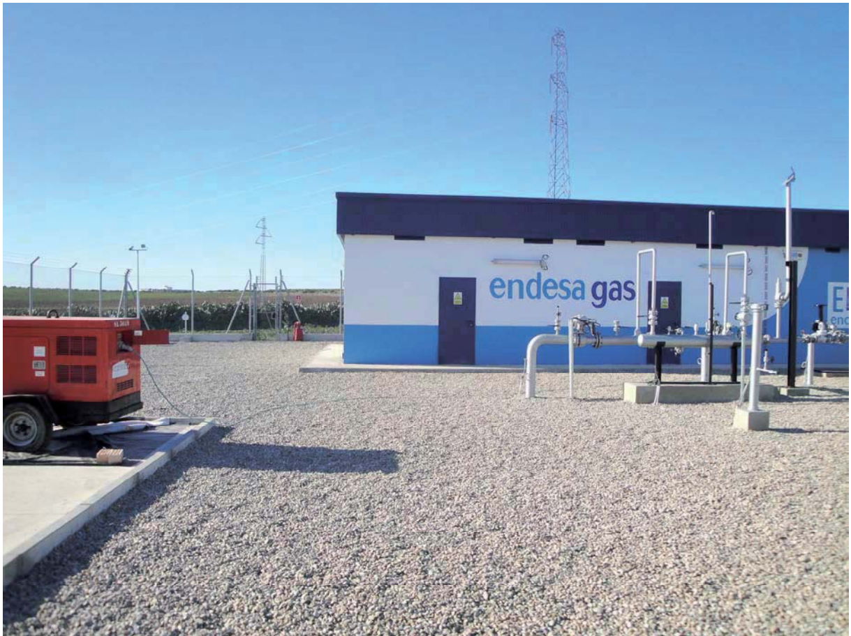
Aspecto final de la posición del Centro Penitenciario del Puerto de Santa María terminada.
