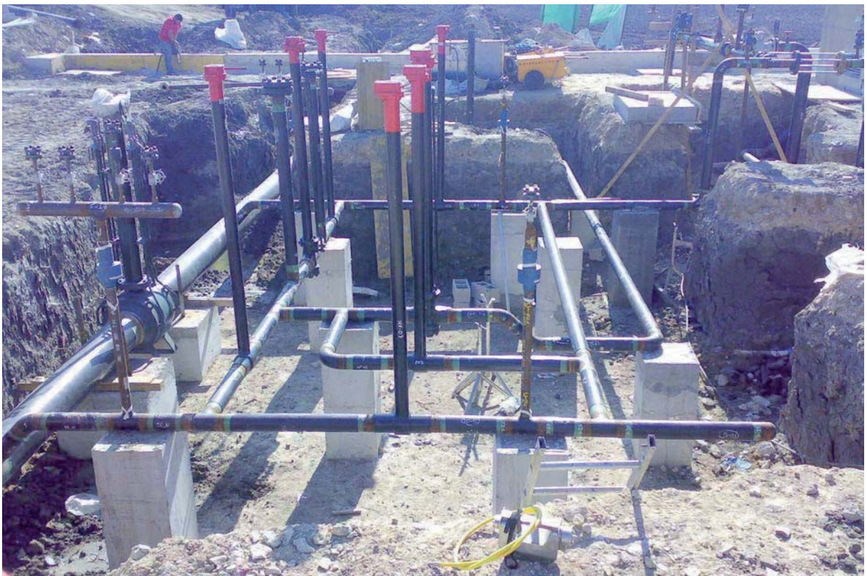
Excavaciones y cimentaciones en la Posición de Rota.
