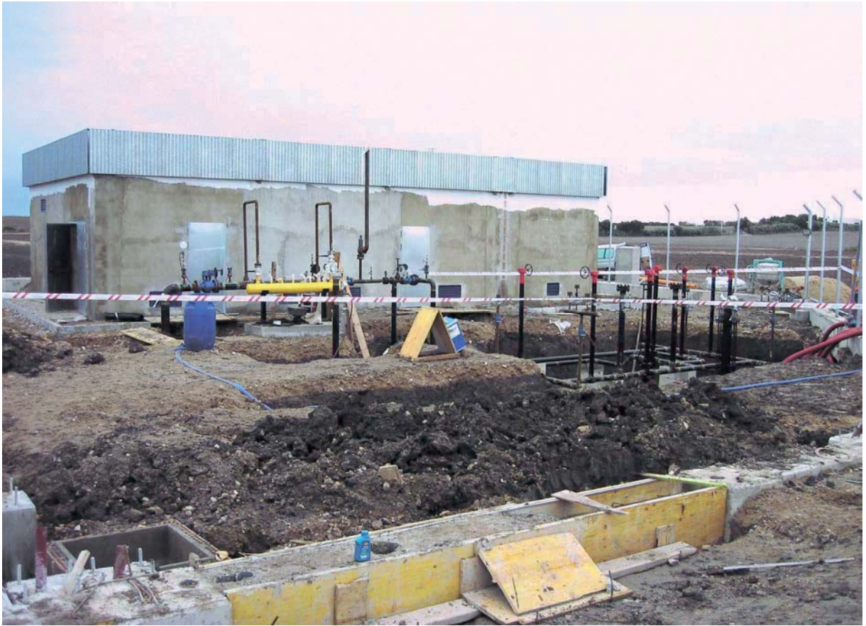
Construcción de edificios auxiliares y del cierre perimetral de la posición de Rota.
