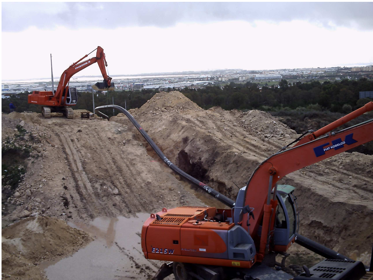
Puesta en zanja de la tubería.
